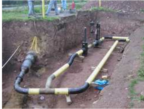
Erfassung der Einbauteile am offenen Graben
