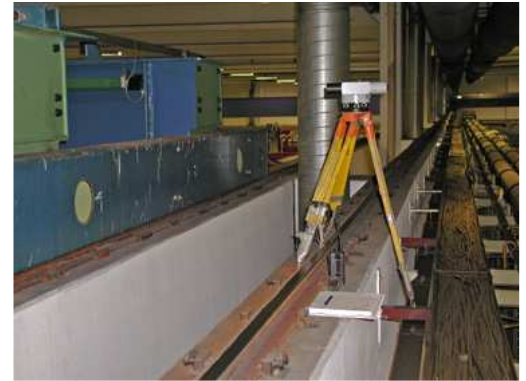
Setzungsmessung mit Nivellement Kranbahn
