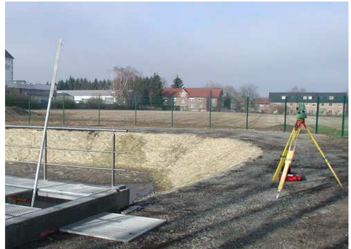
Kanalvermessung mit Kanalmessstab und Totalstation
