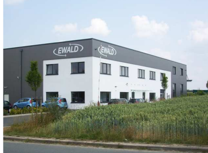
Gebäudeeinmessung nach Fertigstellung
