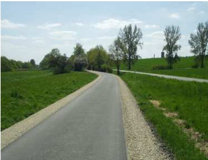
Neubau des Geh- und Radweg
