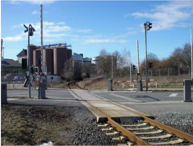
Endausbau der Bahnüberführung
